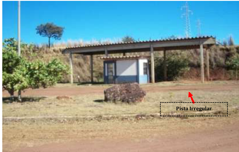
Reservatório de Água
