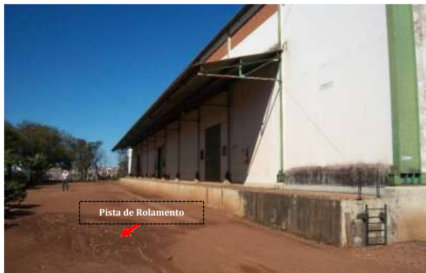
Armazém – Vista Lateral
