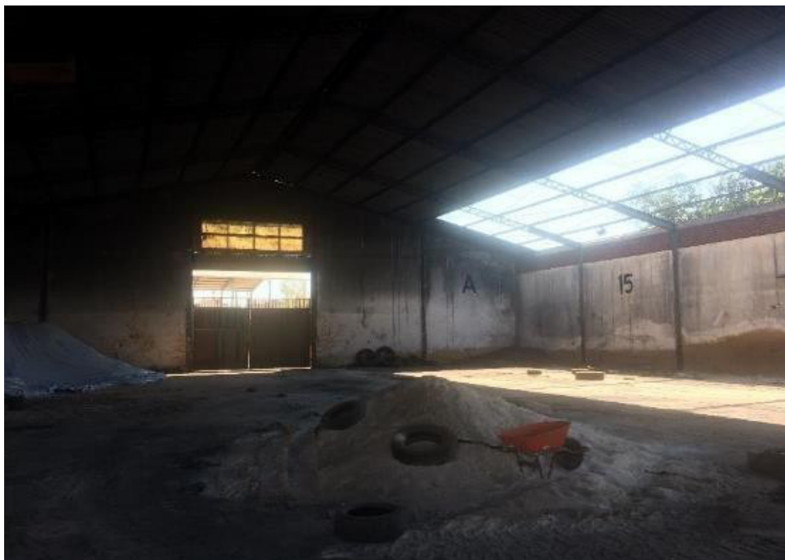
Vista Interna - Armazém
