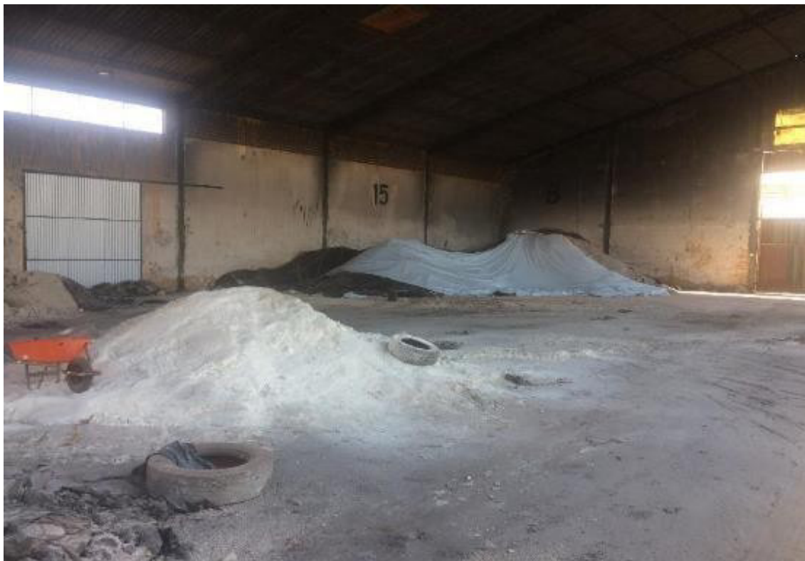
Vista Interna - Armazém
