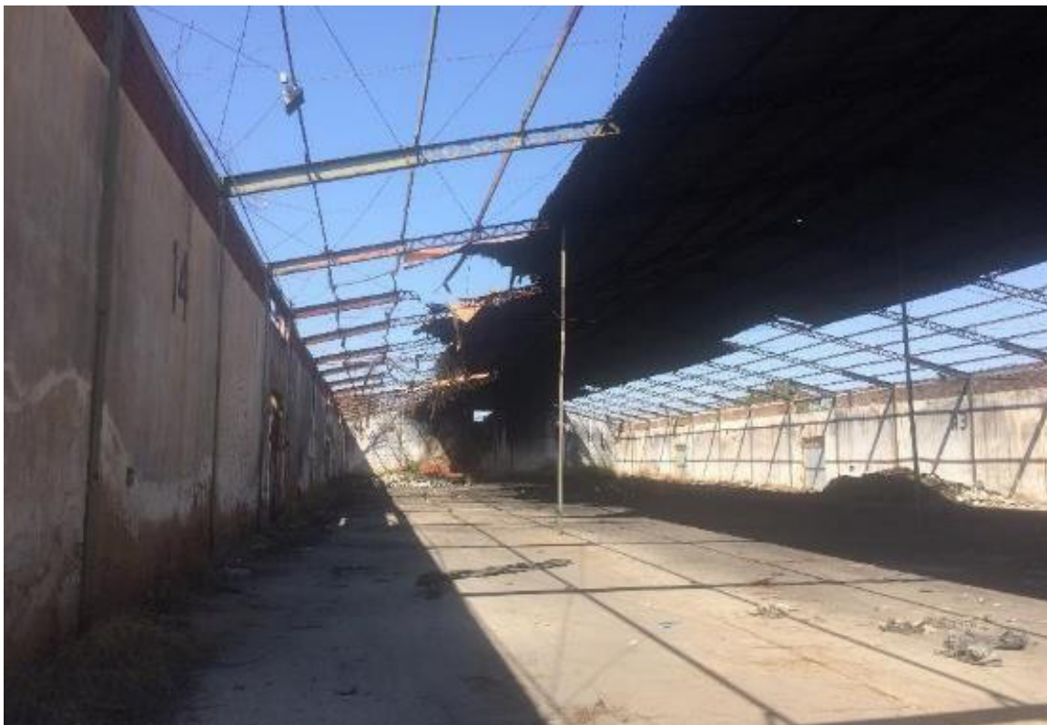
Vista Interna - Armazém
