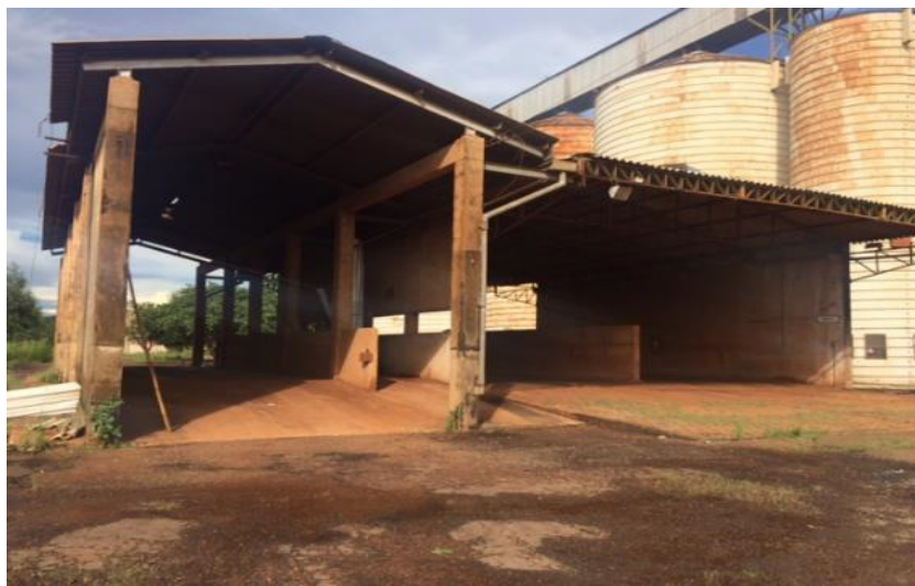
Vista Lateral dos 02 Armazéns
