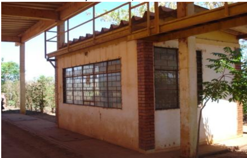
Escritório da Balança Rodoviária/Cobertura da Plataforma
