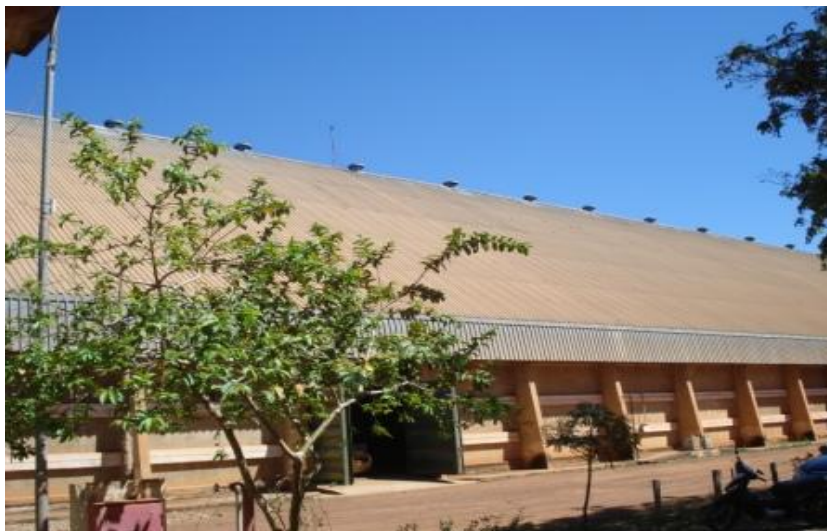
Armazém Graneleiro – 15.000 t. - Lateral
