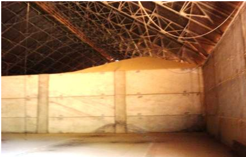
Armazém Graneleiro - Vista Interna
