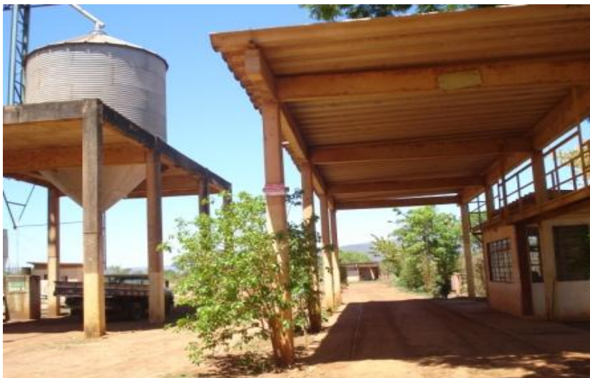
Escritório da Balança Rodoviária/Cobertura da Plataforma
